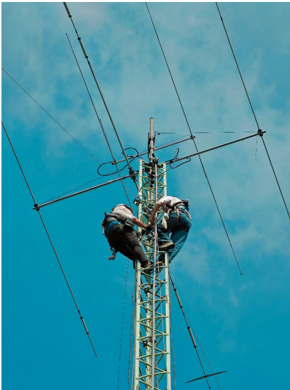
タワー整備の様子
